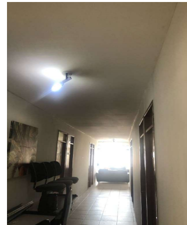
FORRO EM GESSO
