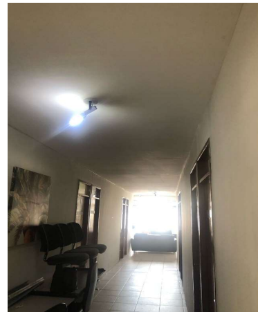
FORRO EM GESSO
