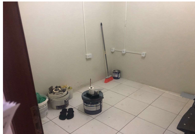
PAREDES EM GESSO A SEREM DEMOLIDAS
