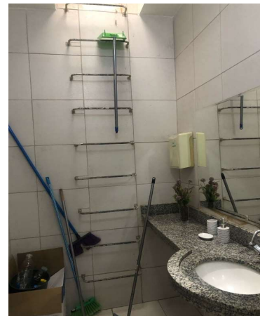
ESCADA MARINHEIRO A SER PINTADA
