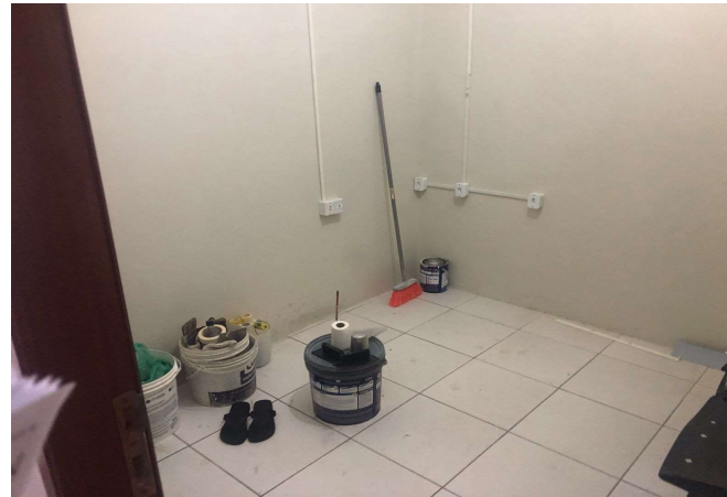
PAREDES EM GESSO A SEREM DEMOLIDAS
